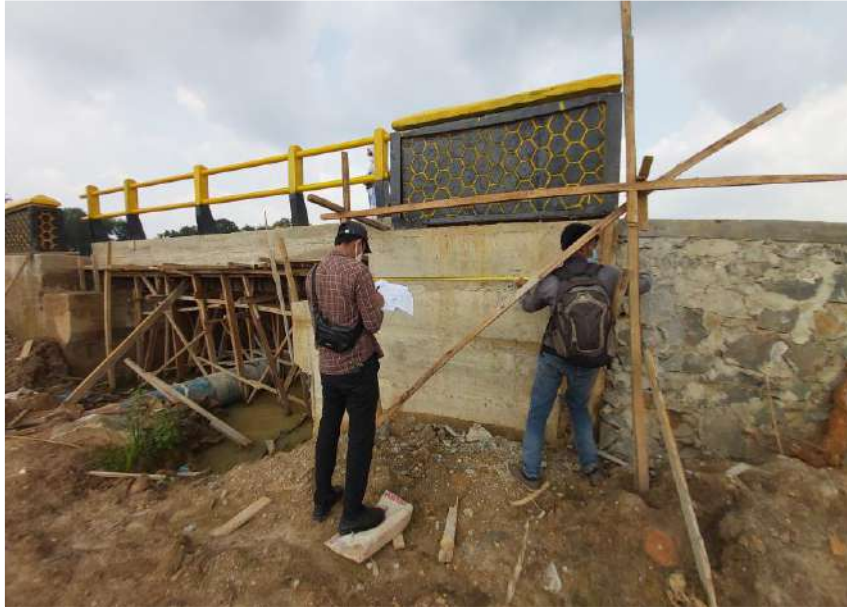
Foto survey Pemeriksaan Kepatuhan atas Belanja Daerah Terkait Infrastruktur Tahun Anggaran 2021 pada Pemerintah Kabupaten Lampung Tengah di Gunung Sugih
